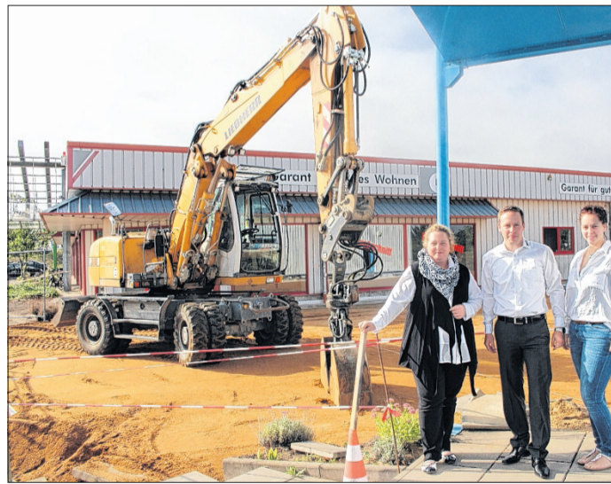
Die Geschäftsleitung, bestehend aus Nicole Spill, Matthias Steinke sowie Britta Spill (v.l.), ist schon gespannt, wie bald das Ergebnis des ersten Bauabschnitts aussehen wird. Foto: C. Arendt-Nowak
